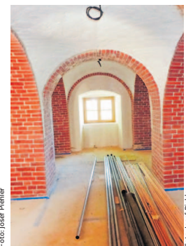
Der Gewölbekeller wird der neue Aufenthaltsraum für die Polizeihochschüler.
