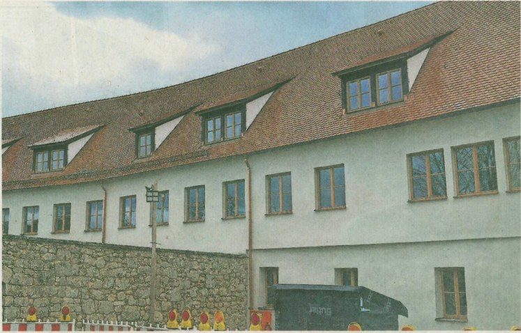
So sieht das Unterkunftsgebäude nach der Sanierung aus.
