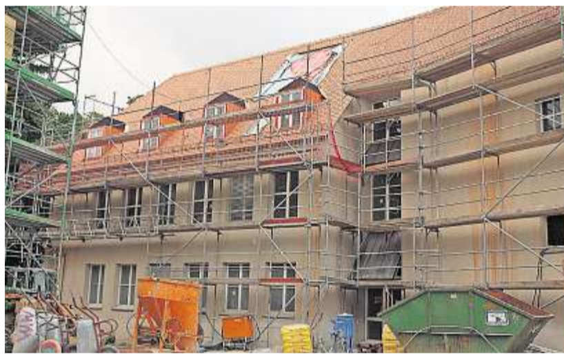
Wie hier werden alle Gebäudeteile mit Biberschwanzziegeln gedeckt. FOTO: HUBERT SÖLLNER
